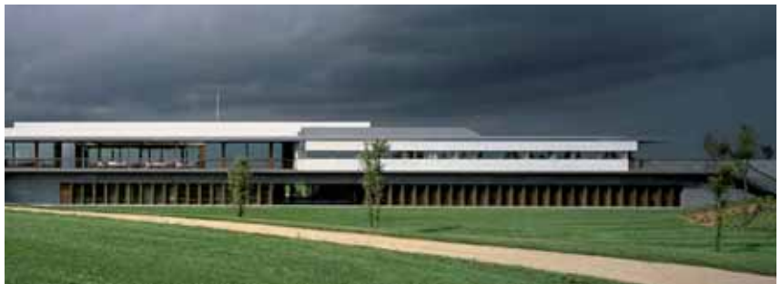
La magnífica casa club actual está perfectamente integrada en el entorno
